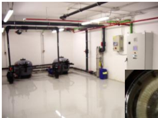
Инсталация за пречистване на водата от езерото
